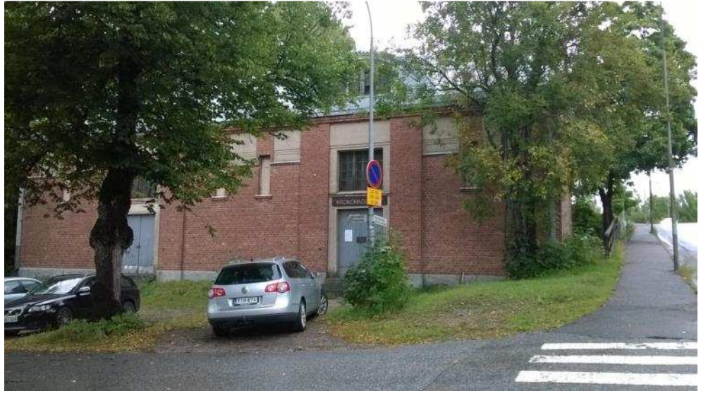
Kruununmakasiini on rakennettu vuonna 1911. Rakennus on nykyisin Tammisaaren kaupungin varastona. (Kuva Eeva Eitsi)
