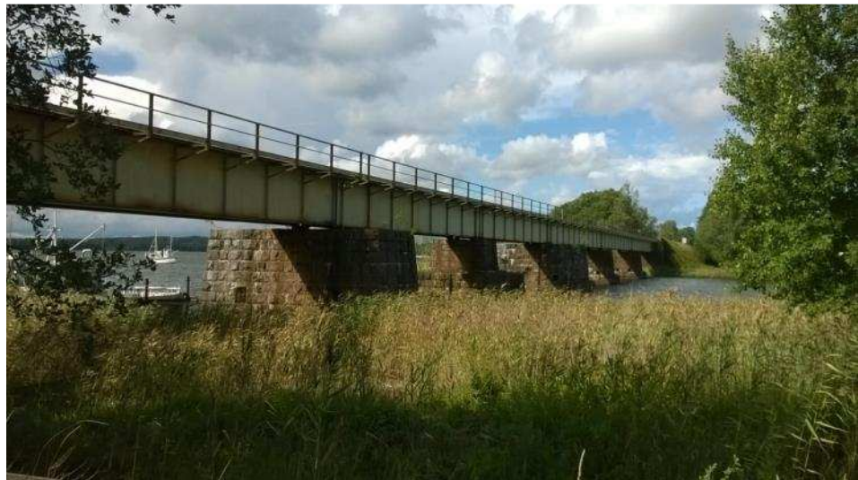
Nykyinen rautatiesilta rakennettiin 1910-20. Silta on osin uusittu. Huomion kiinnittävät komeat lohkokivistä vuoratut virtausarkut ja lohkokivistä muurattu maantien alikulkusilta, joka toimii nykyisin kevyenliikenteen alikulkuna.
